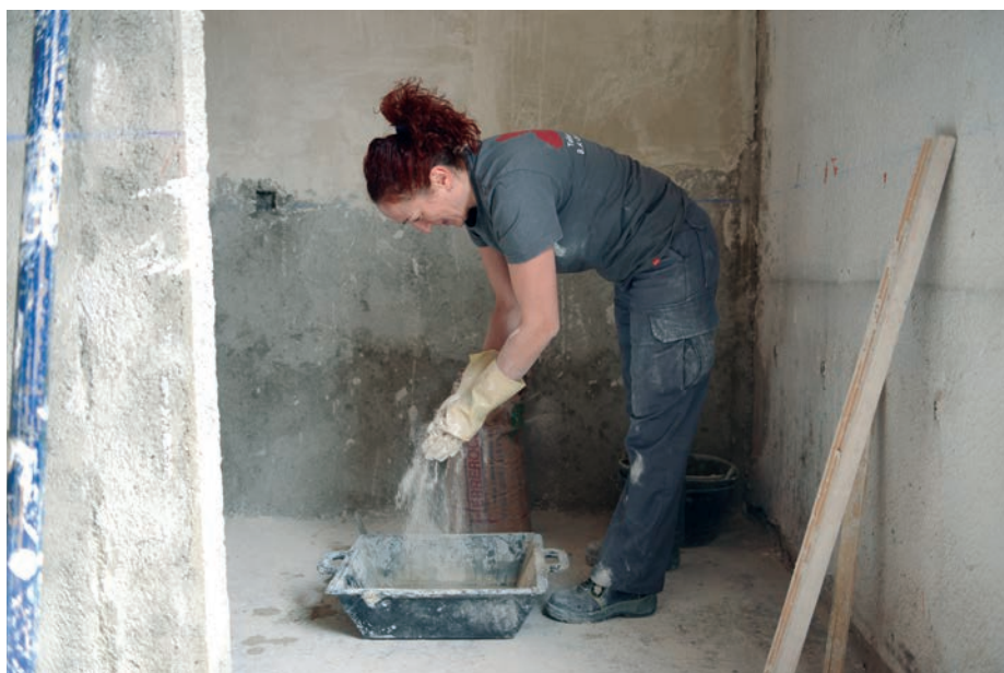
Las labores de albañilería que se realizan en el Taller de Empleo de Cuatro Vientos son muy beneficiosas para el mantenimiento de la base aérea.
